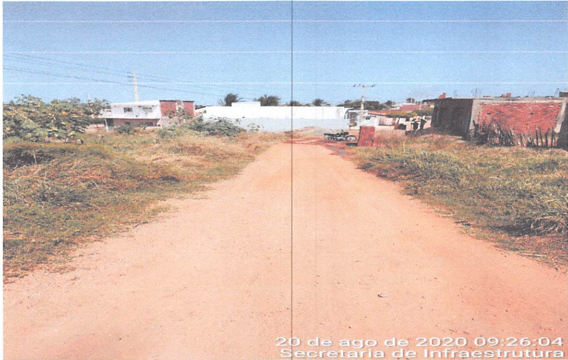
Figura 9 – Local da Pavimentação
