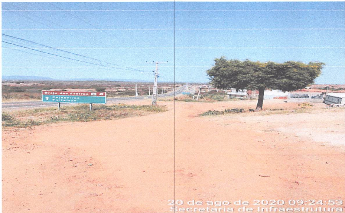
Figura 5 – Local da Pavimentação
