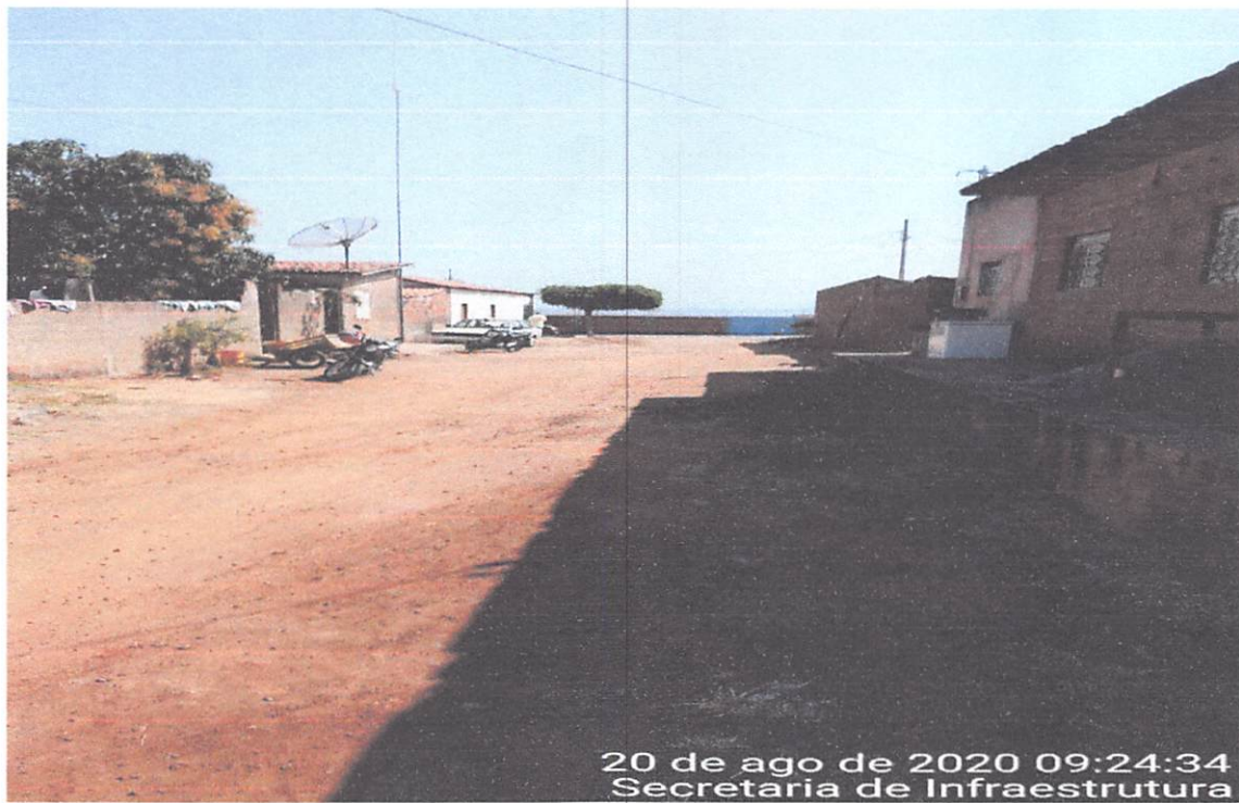
Figura 3 – Local da Pavimentação
