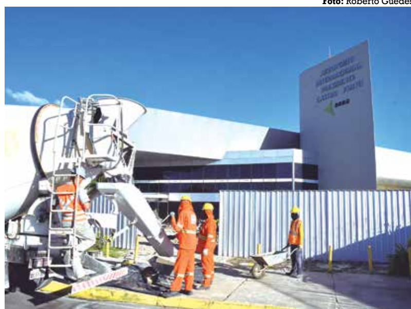
Algumas áreas do Castro Pinto estão fechadas para realização da ampliação
